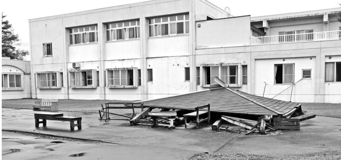
崩壊したあずま屋は屋根がかろうじて以前の姿を残す
